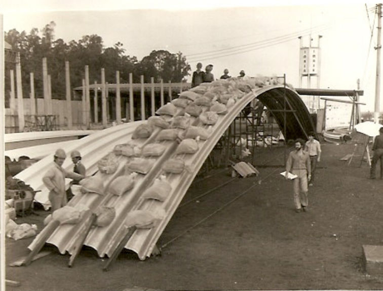
Fotografia 7 - 1º ensaio 7ª fase de carregamento.
