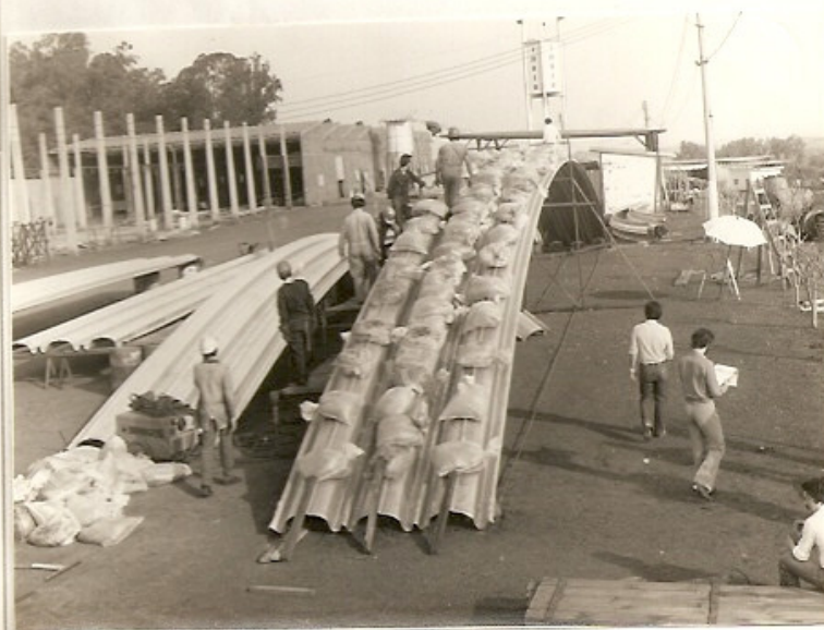
Fotografia 8 - 1º ensaio 8ª fase de carregamento.
