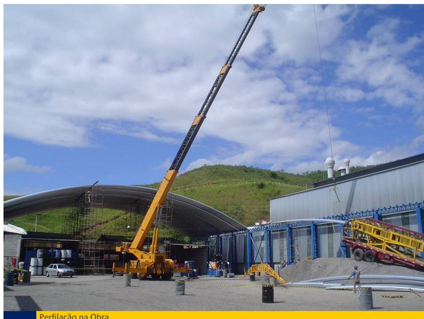
Perfilação na Obra
