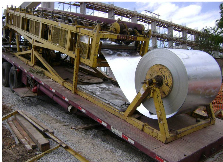
Perfilação na Obra
