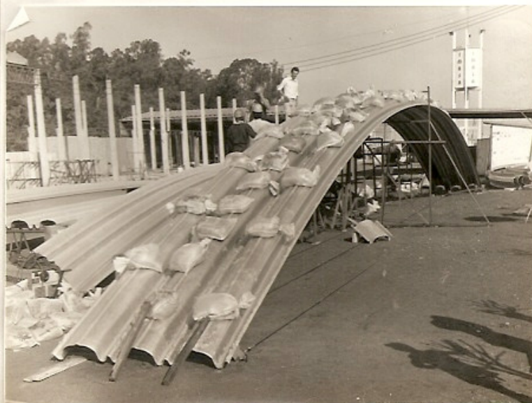
Fotografia 6 - 1º ensaio 5.ª fase de carregamento.
