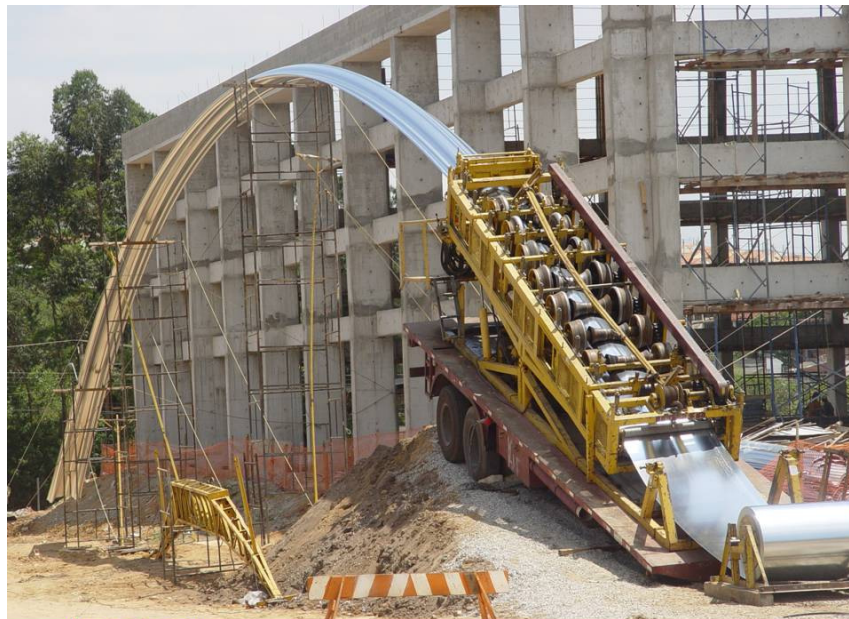
Perfilação na Obra
